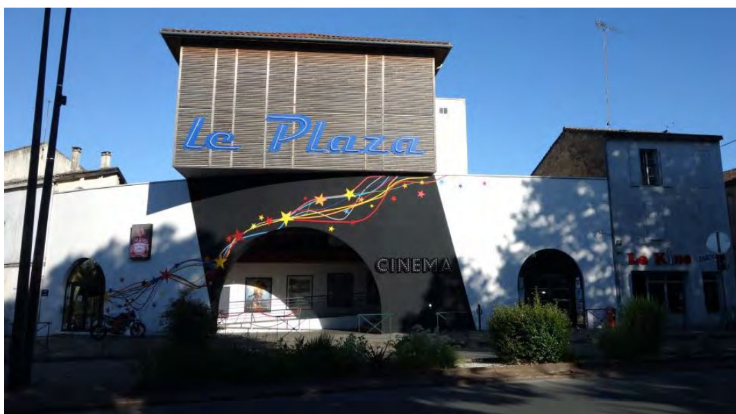
La façade du PLAZA à Marmande
