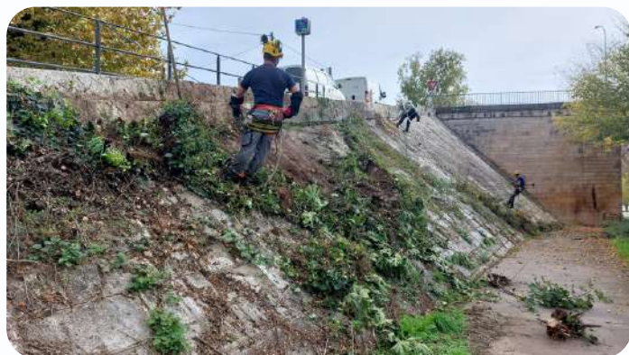
A gauche : nettoyage des empièvements de la digue d'Aiguillon, en 2024 A droite : reprise de la digue de "Pélagat-Sautegrue" à Aiguillon, en 2023
