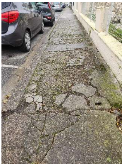
Figure 2 : Trottoir dans la rue de Visé
