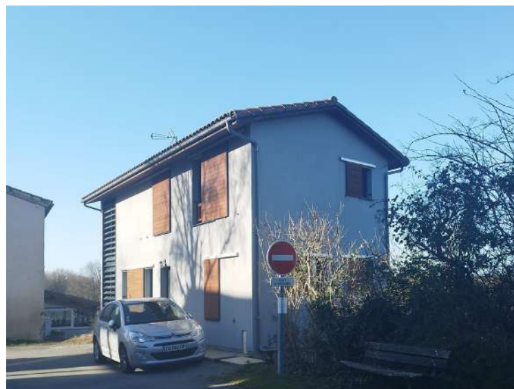
Une opération de renouvellement
