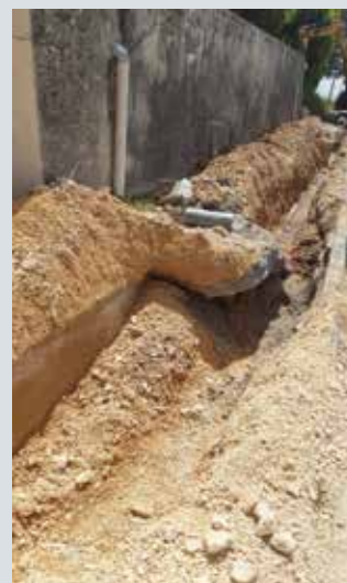
Tranchée technique réalisée
