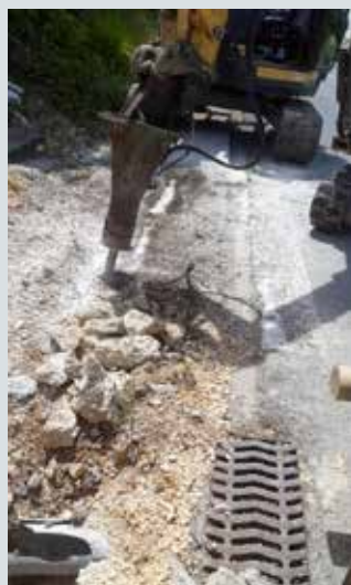
Démolition au BRH
