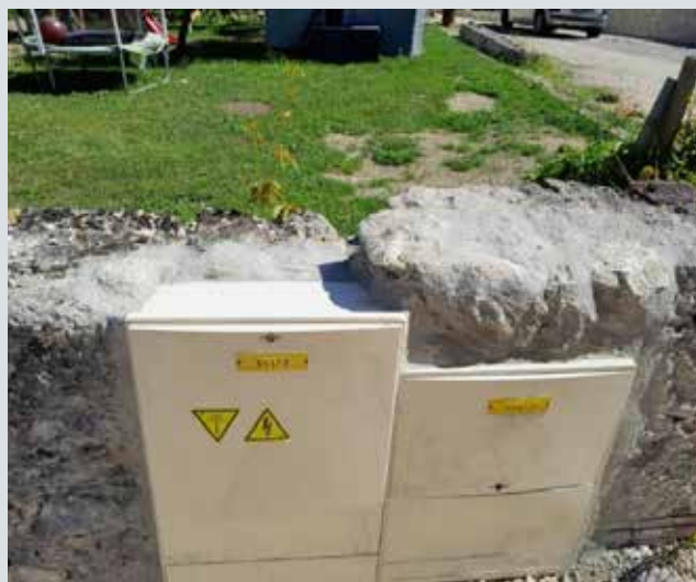
Encastrement de coffret de réseau électrique
