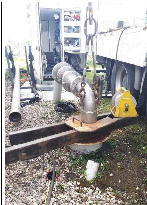
Forage de Lagravette à Lafitte sur Lot
