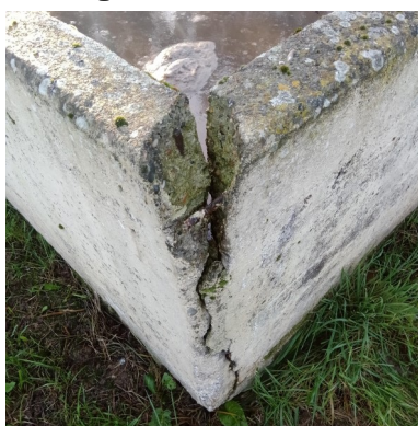
Angle du bassin d'aération
