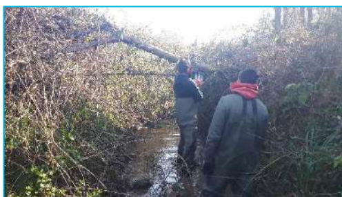
Ouverture du lit d'un cours d'eau
