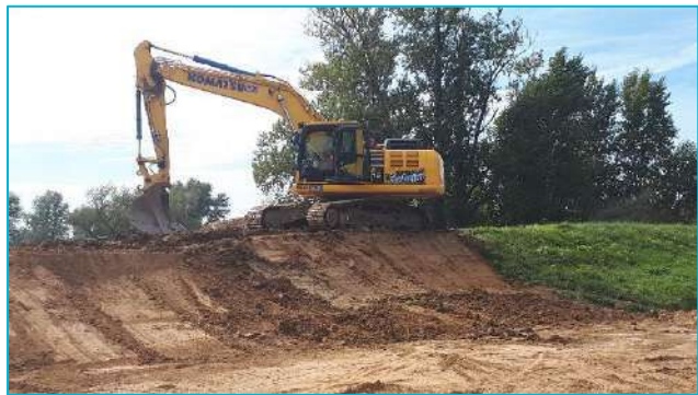
Travaux sur la digue de Port-Sainte-Marie
