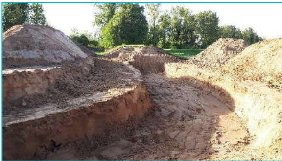
Fondation de la digue de Port-Sainte-Marie
