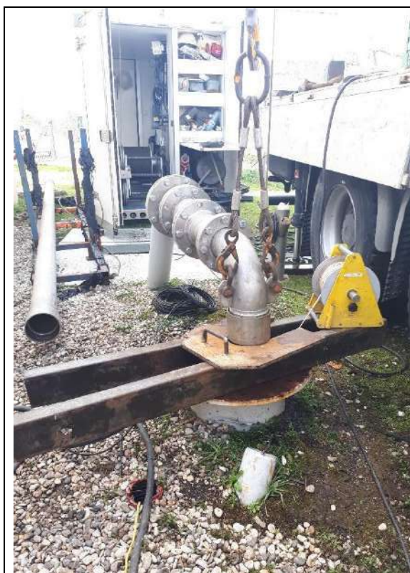
Forage de Lagravette à Lafitte sur Lot
