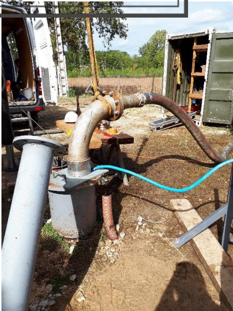
Forage de Monplaisir, à Savignac-sur Leyze
