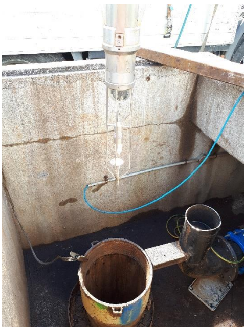
Forage de Brot, à Clairac
