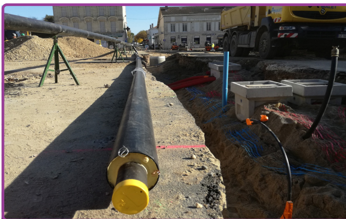
Installation du réseau de chaleur à Aiguillon
